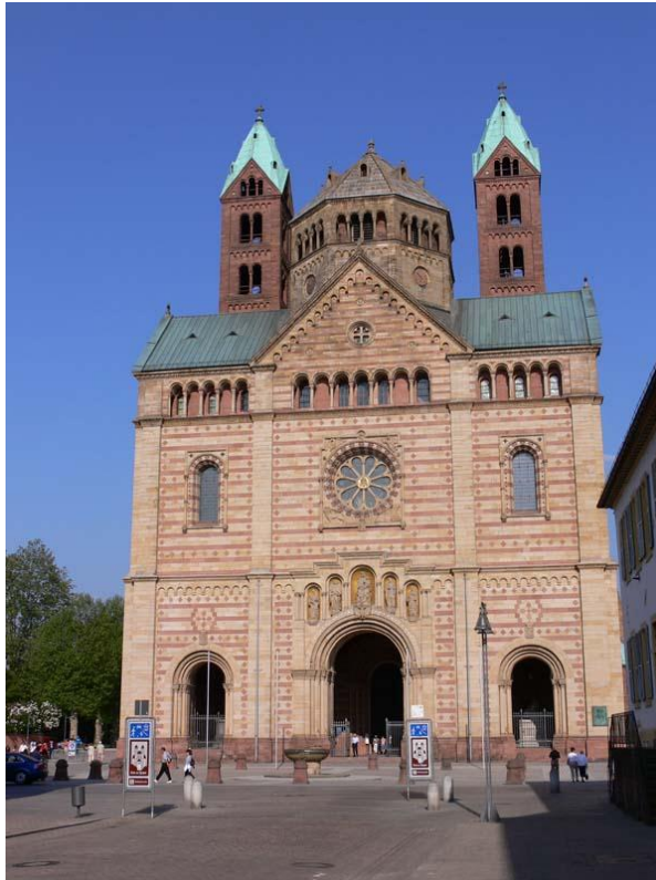
Speyer – Alemania- vista de fachada
